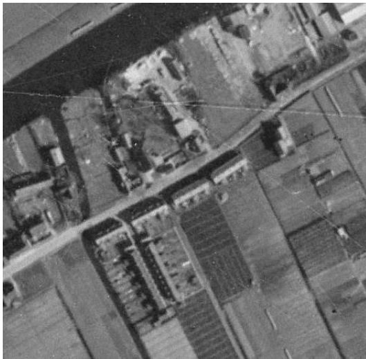
Woningcomplex met vier rijtjes langs de Straatweg.
