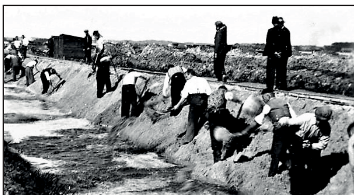
Sloten werden gedempt. Het zand werd aangevoerd en aangestampt om het terrein af te vlakken.
