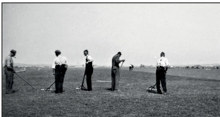
Vervolgens werden er graszoden gelegd en gras ingezaaid.
